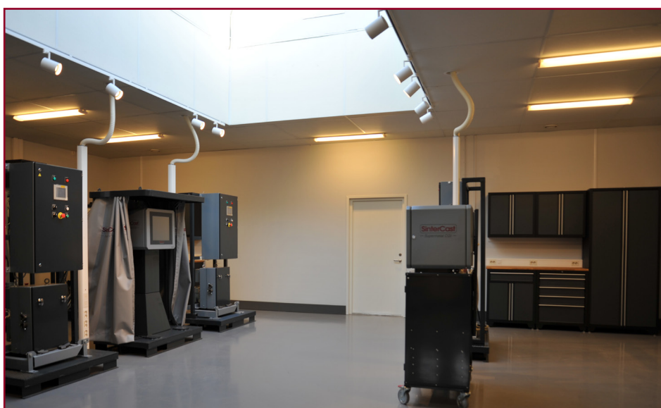
Under 2016 renoverades lokalerna vid Technical Centre i Katrineholm, vilka förstärker den högteknologiska image som SinterCast har. Här visas configuration och test av utrustning.
